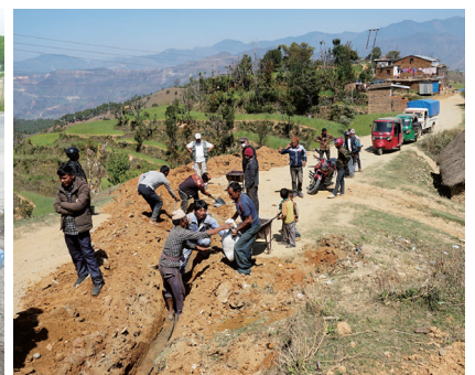
ネパール連邦民主共和国での村民ボランティアによる敷設工事 (2018 年度)
