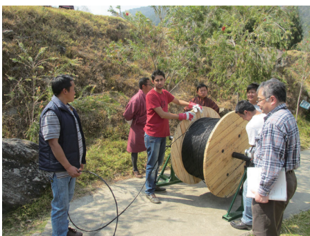
ブータンでの敷設工事 (2011 年度)
